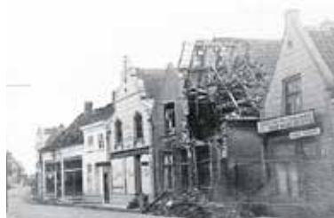
Oorlogsschade van pand Van Dartel aan de Steenstraat.
